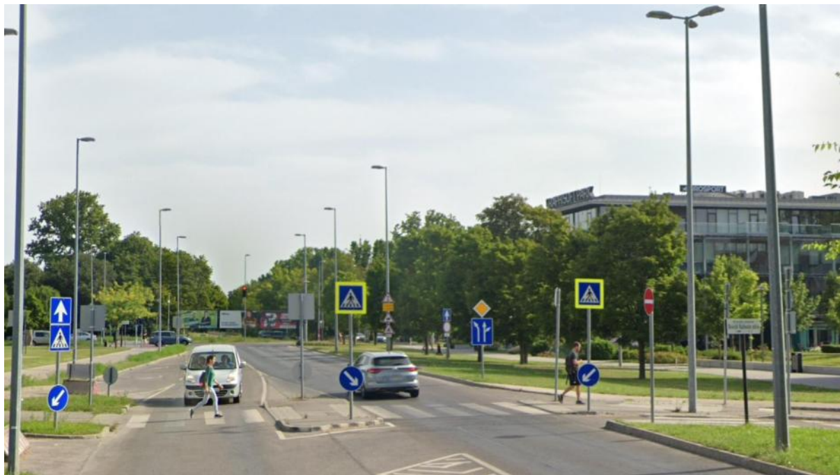
Ángel Sanz Briz úti meglévő középszigetes gyalogátkelő, Graphisoft park egyirányú kihajtóval
